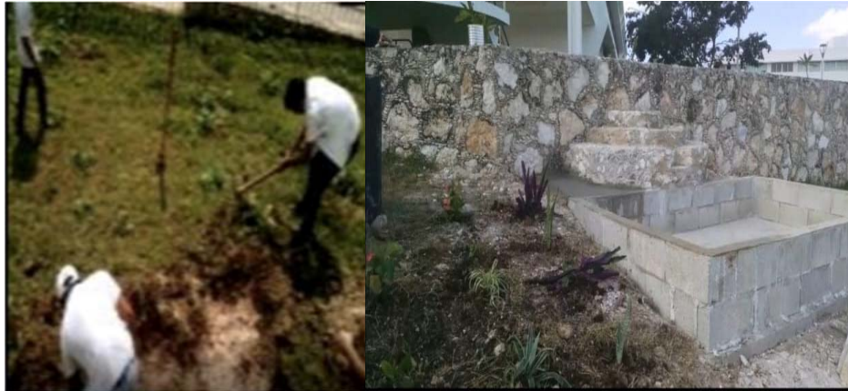
Figura 12 Proceso de construcción del sistema de captación de agua de lluvia.
