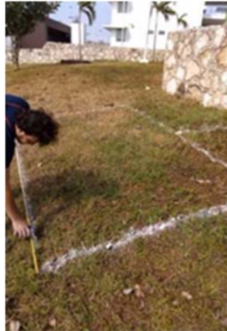
Figura 11 Preparación del área del sistema de captación de agua lluvia.
