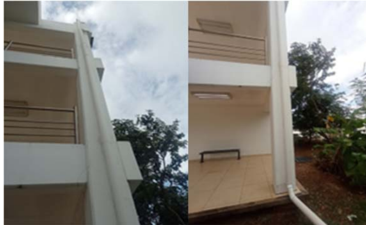
Figura 14 Recorrido del agua de lluvia por tubería de 1 pulgada.
