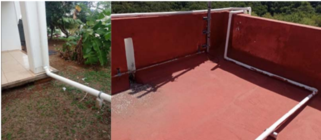
Figura 15 Azotea del edificio B de la facultad de ingeniería.
