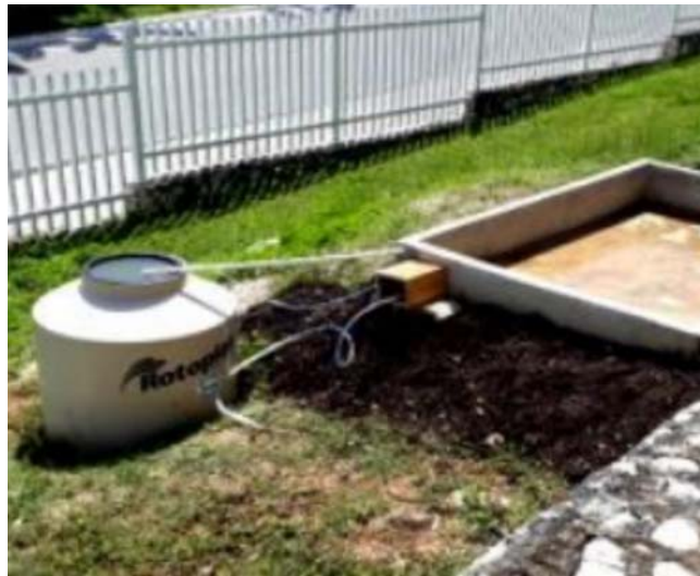
Figura 13 Instalación de tanque de almacenamiento con capacidad de 1100 litros.
