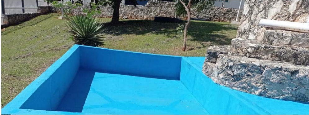
Figura 16 Estante del sistema de captación de agua lluvia.
